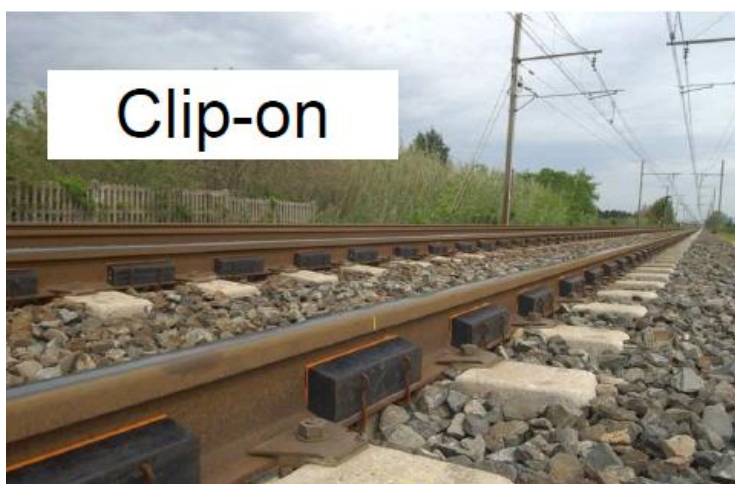
Figura nr 4: Amortizor de zgomot CORUS, aplicat
